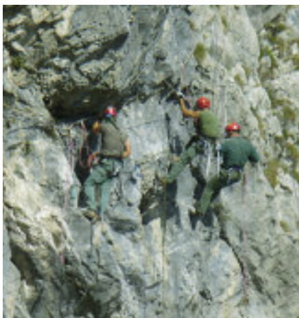
Istruttori della Julia mentre attrezzano la via ferrata a Pontebba.
